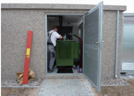
SLFBH Öltrafo für PV-Station SLFBH Oil transformer for PV shelter station
