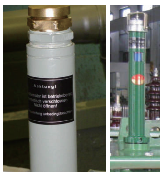
Gasdruckventil oder Ölstandanzeiger mit Gasdruckventil gas pressure valve or oil level indicator with gas pressure valve
