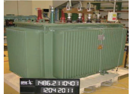
Erwärmungsprüfung US-Seite bei der IPH Temperature-rise test LV-side at IPH
