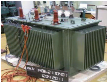
Erwärmungsprüfung OS-Seite bei der IPH Temperature-rise test HV-side at IPH
