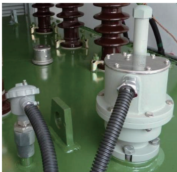
PT100 Sensor und QYW9 Schutzgerät zum Messen von Öltemperatur, Ölgas und Öldruck PT100 sensor and multiple protection device for measuring of oil temperature, oil gas and oil pressure
