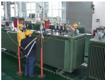
Routineprüfungen für ein Ölrafo Routine test for an oil-filled transformer
