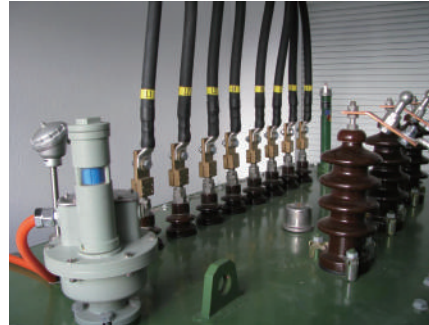
SFLBH Öltrafo mit Zwei NS-Wicklungen SFLBH transformer with two LV-windings
